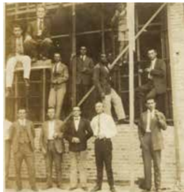
Construção do ateliê de Lasar Segall / Construction of Lasar Segall's studio, 1932
